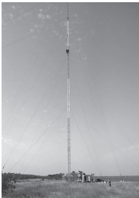
Рис. 15. Монтаж ультразвукового детектору Pettersson D500x на висоті 42 м на метеорологічній вежі Запорізької ВЕС
